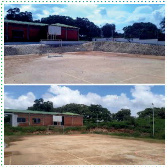
Adecuación de cancha deportiva del Centro educativo Divino Niño, Vereda La Puerta - Astrea, Cesar.
